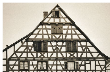
Süddeutsche Bautradition: Die Ostgiebelfront mit dem dreifachen Vorkrag. Aufnahme von 1958.
