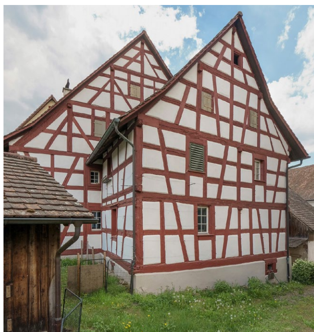
Von Osten aus betrachtet kommt das Fachwerk des ursprünglichen Kelhofs besonders gut zur Geltung.
