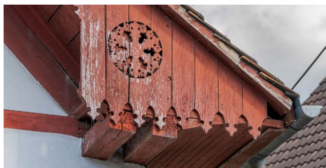
Fein gearbeitete Flugsparrenzier mit ornamental ausgesägten Ort Brettern und Pfettenabdeckungen.
