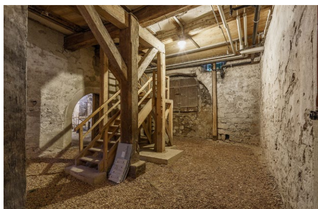
Zum Adler gehören riesige Kellerräumlichkeiten. Das Kreuzgewölbe (oben) und der Balkenkeller mit Treppe (Mitte) sind vermutlich 1805 entstanden, das Tonnengewölbe (unten) dürfte aber vom Vorgängerbau stammen.
